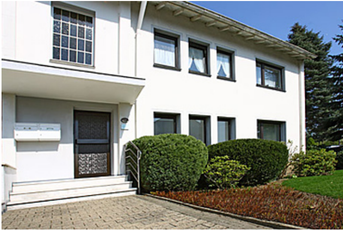
Eingangsbereich des Hauses
