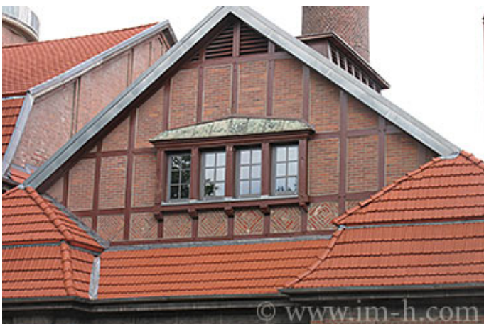
Bildausschnitt vom Kesselhaus
